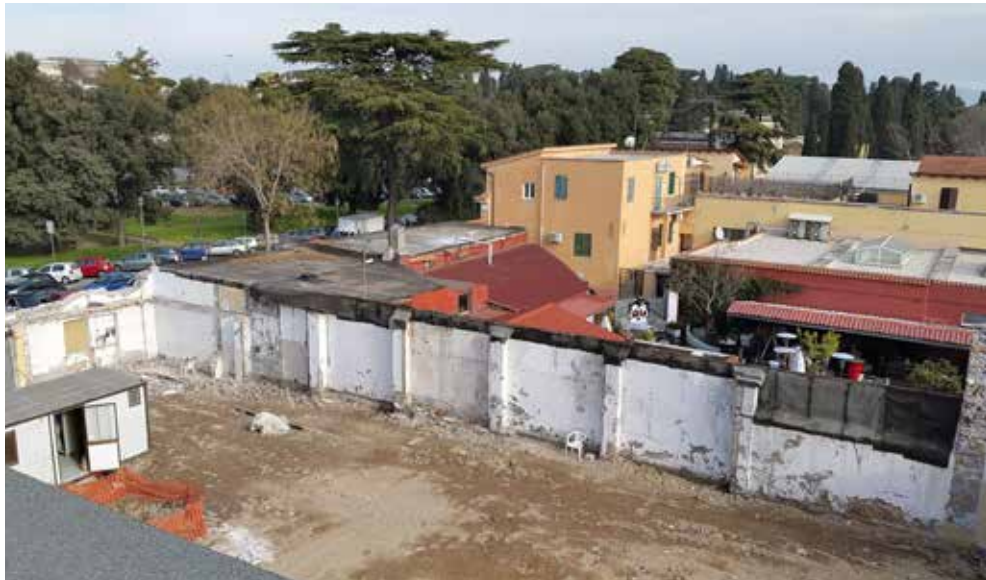
Fig.4 Vista dall'alto dell'area demolita dell'ex smorzo in Piazzale del Verano. Al tessuto-logistico produttivo in crisi si sostituiscono inesorabilmente miniappartamenti.
